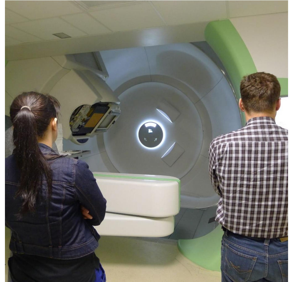
Stanowisko terapeutyczne gantry z wiązką skanującą w IFJ PAN Kraków
