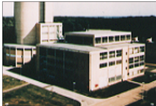
AVR, Niemcy 15 MWe 1967-88
