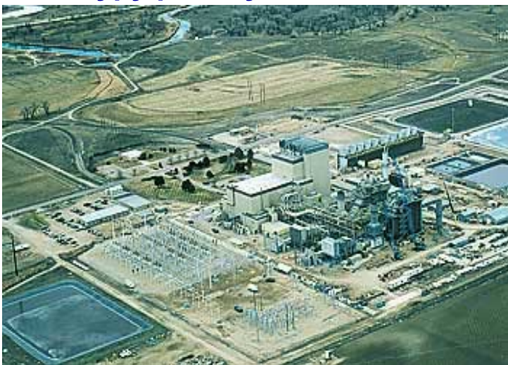
Fort Saint-Vrain, USA 300 MWe 1976-89
